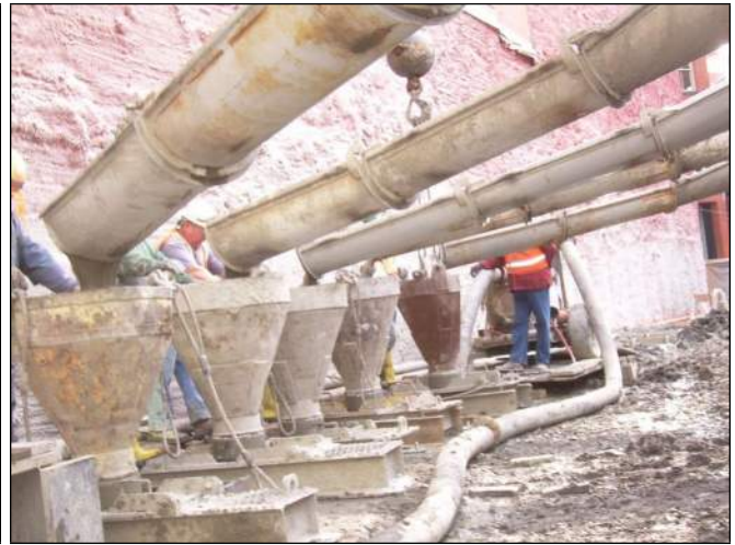
Concrete Pour with Five Tremie Pipes
