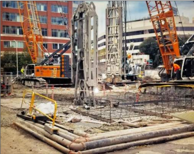
Slurry Wall Production
